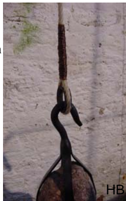
Houtteer in gebruik bij een gewicht van een historisch torenuurwerk.
