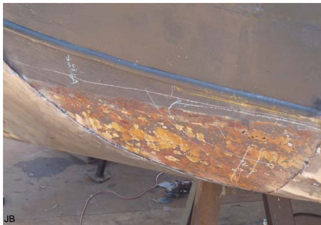
Over gaten heen dubbelen kan een corrosie probleem opleveren!
