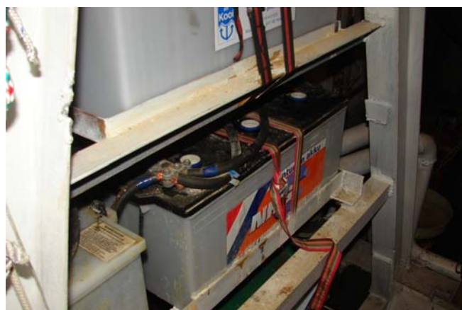
Constructie is niet geïsoleerd, kabels zijn slecht gemonteerd en de accu kan schuiven en is vies...
