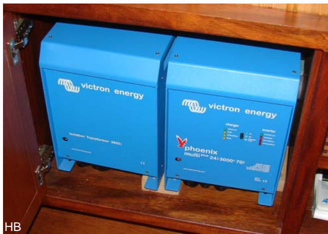
Een mooi systeem met een eigen aarde voor het 230V boordnet.
